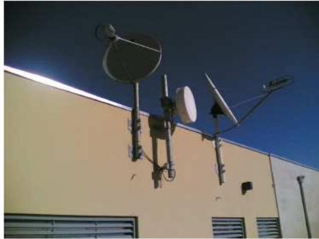
Figura 18: Antenas utilizadas para acesso, via satélite, à internet e serviço telefônico.
